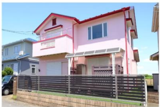
★三井ホーム施工のお建物★
